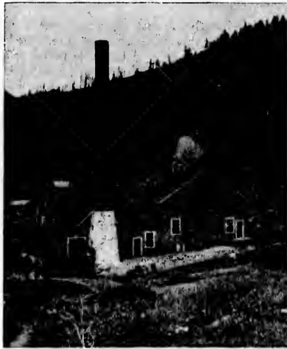
LE ROI COMPRESSOR PLANT—ROSSLAND, B.C.
